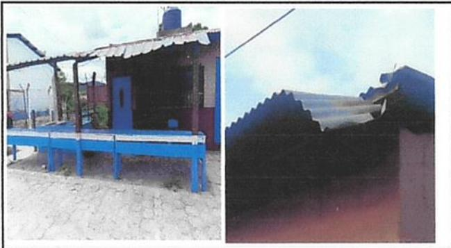
Foto1: Demolición e instalación de cubierta de techo de cocina y bases y techo de galera de área de pila y servidor de alimentos.
