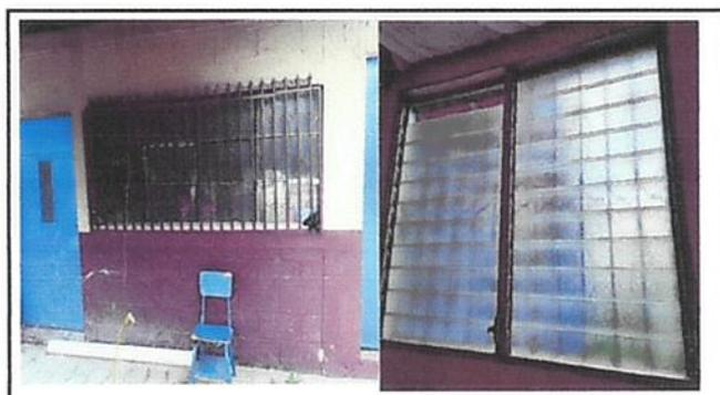
Foto 4: Sustitución de ventanales por ventanas de PVC.
